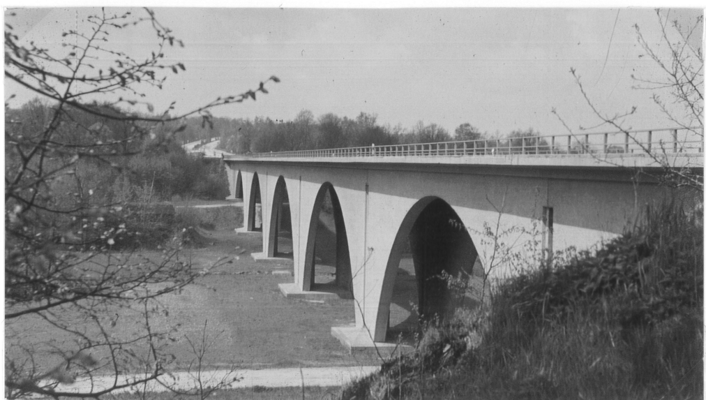
Zweite Autobahnbrücke Nordseitige Fahrbahn erbaut 1951-1954, südseitige 1972-1974 — Juli/Anf. Aug. 1995 vor Neubau 2er Fahr- bahnen an der Nordseite gesprengt.
