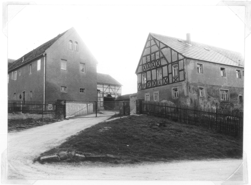
Aufnahme v. 19. 4. 1937 Wohnhaus Jan. 1929 abgebrochen
