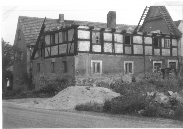
"Beigut" "Wohnhaus im Abbruch
